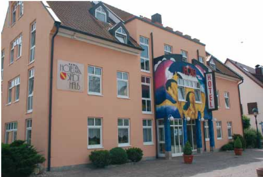
Beheizt mit oberflächennaher Erdwärme: das Hotel am Stadthaus; Foto: Annika N. Willscheid
