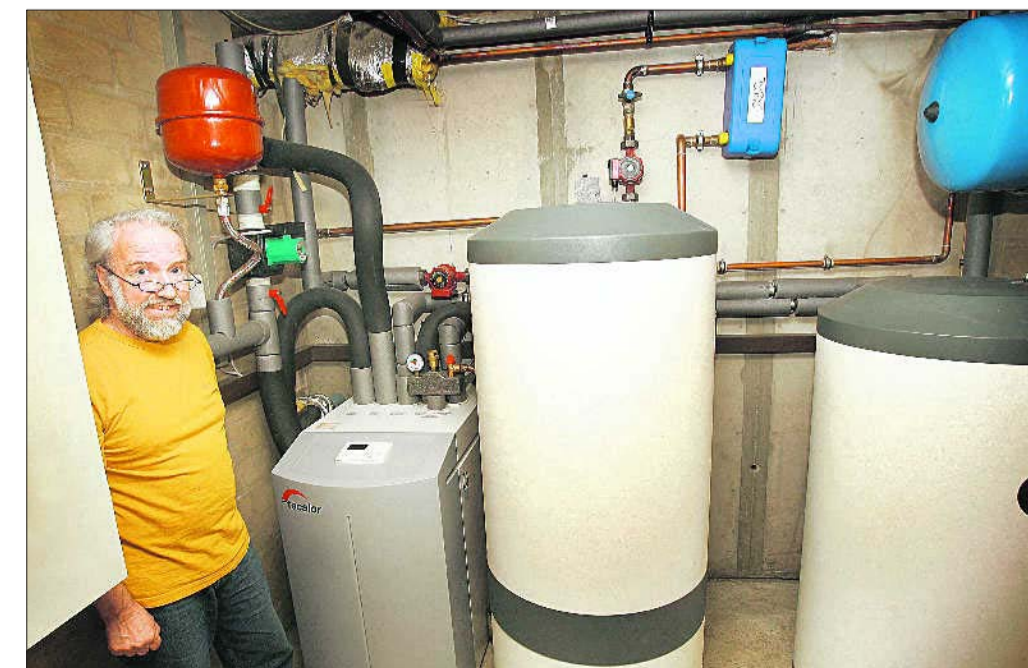
Stolz auf seine Geothermie-Heizung: Gert Weber holt die Heizwärme für sein Einfamilienhaus in Schlesien (Kreis Plön) aus den Tiefen der Erde. Foto JJK
