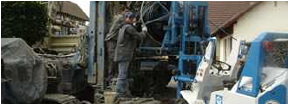
Anlieferung der Doppel-U-Rohrsonden Foto: Stoltenberg
